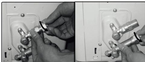
5.4 Aalignez les tuyaux puis vissez à la main les écrous de vissage aussi fermement que possible.
